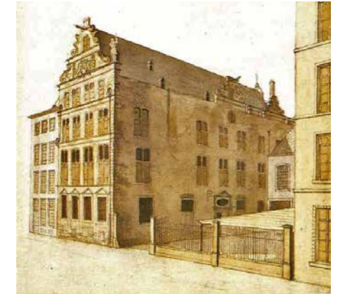
Haus der Fassbinderzunft, Filzengraben errichtet um 1539
