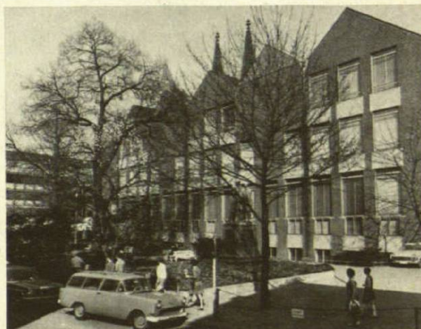
Kölns berühmteste Gemälde-Galerie, das Wallraf-Richartz-Museum, wurde 1955/56 von den Architekten Schwarz und Bernard erbaut. Foto: Verkehrsamt Köln / F. Damm
