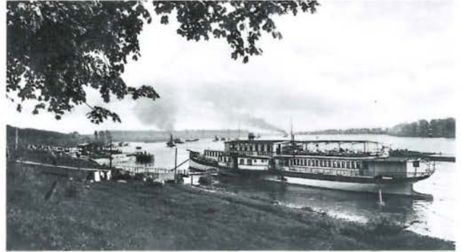
Liegeplatz als Restaurationsschiff in Benrath ab 1932. Beachte: Das Bootshaus auf dem Heck
